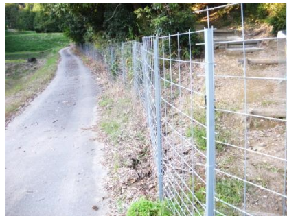
道に沿って山側に設置された柵。右手の階段状の道への出入りも仕切られている。
