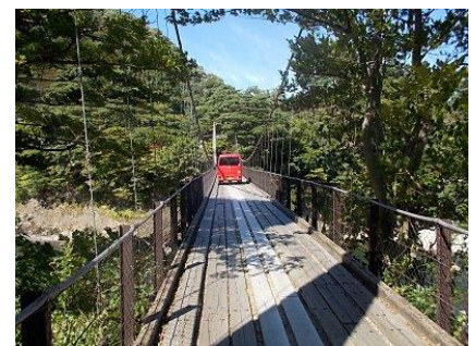
鷹の巣温泉の木造吊り橋。郵便車が通ると橋が歪む。目で見て判る。橋を歩くと気持ち悪い揺れ方をする。
