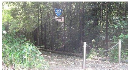
テレイン内で見た酷道(国道)308号車止めのある国道って・・・ナニ？
