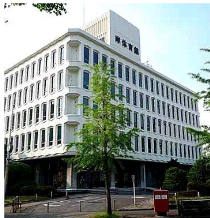
JOA 事務局の入る岸記念体育館。 日本体育協会の本部ビルであり、日本オリ ンピック委員会も入居している。
