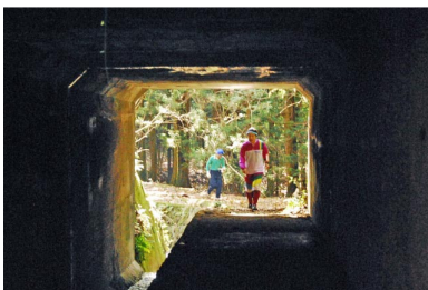
トンネルを抜ける
