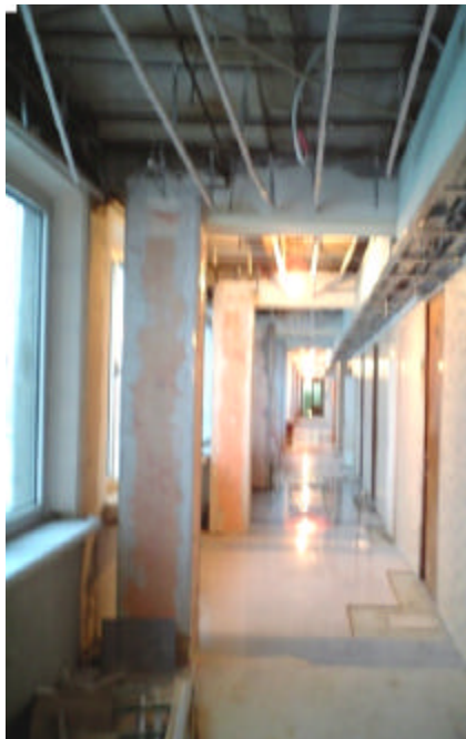
工事中のモスクワオリンピックホテル
